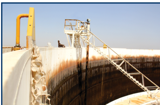
آزمون عملکرد سیستم فوم دوزینگ Foam dosing system operation test
